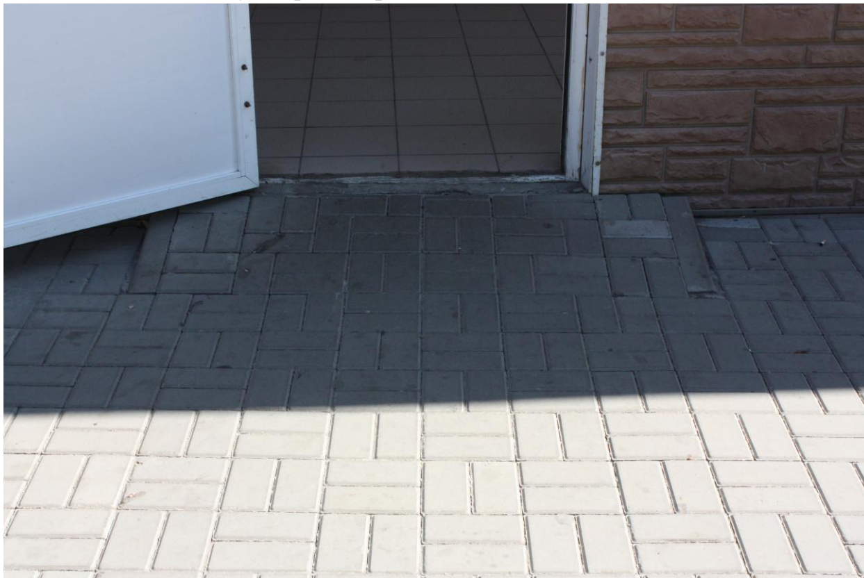
Фото № 5. Пандус перед дверью (Входная площадка)
