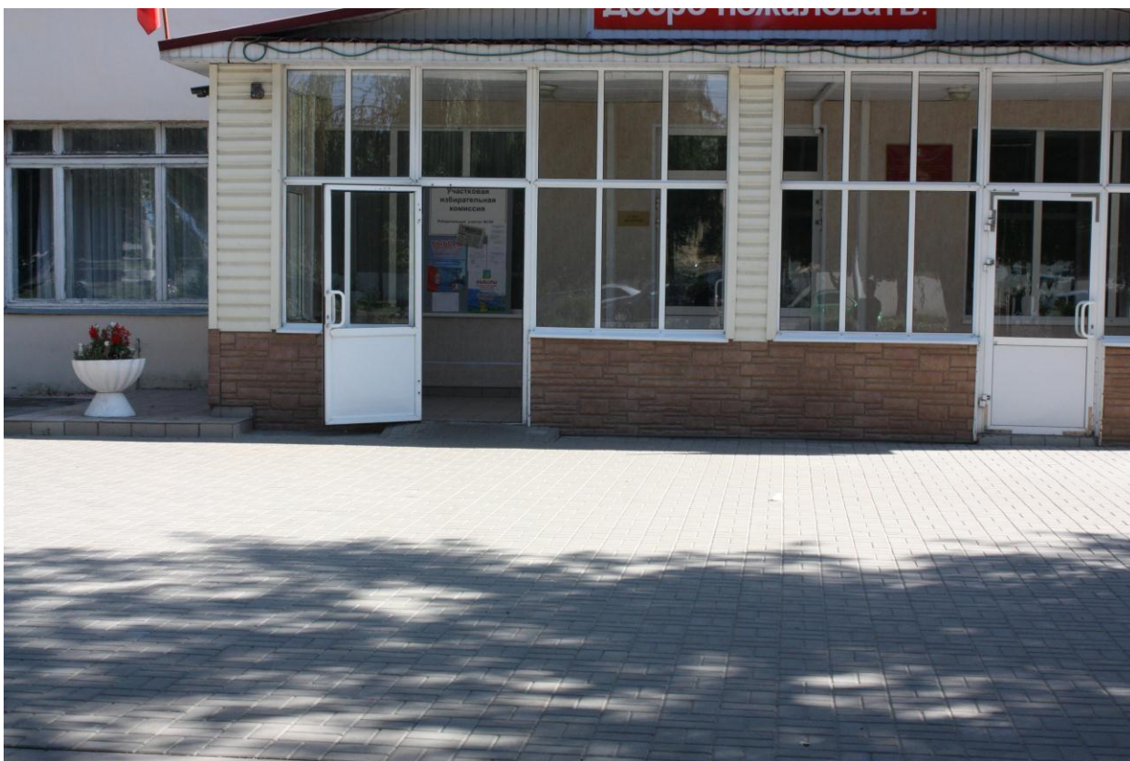
Фото № 4. Вход в здание.
